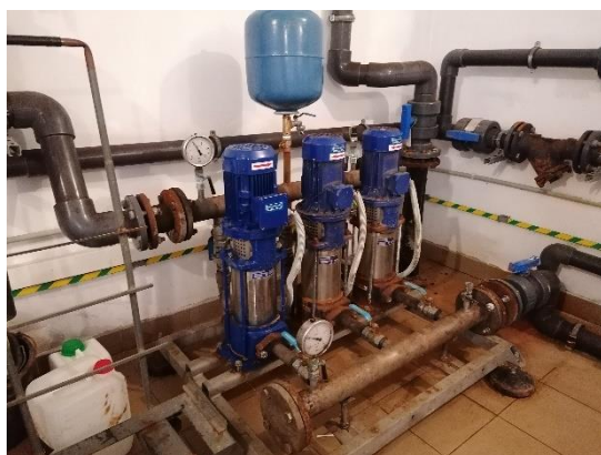
Zdjęcie 3 Stacja hydroforowa
