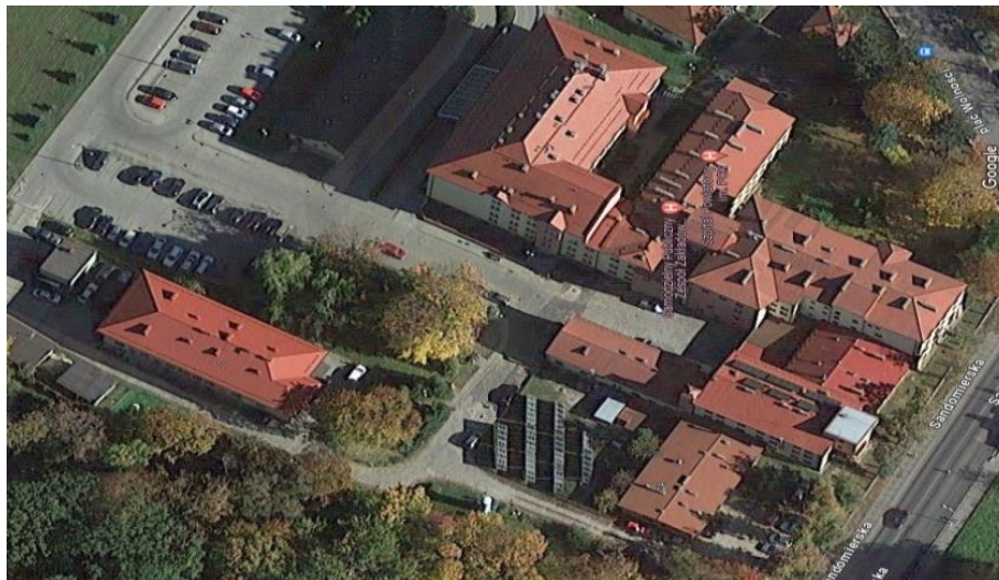
Zdjęcie 1 Widok ogólny obiektów szpitala SPZZOZ w Nisku
