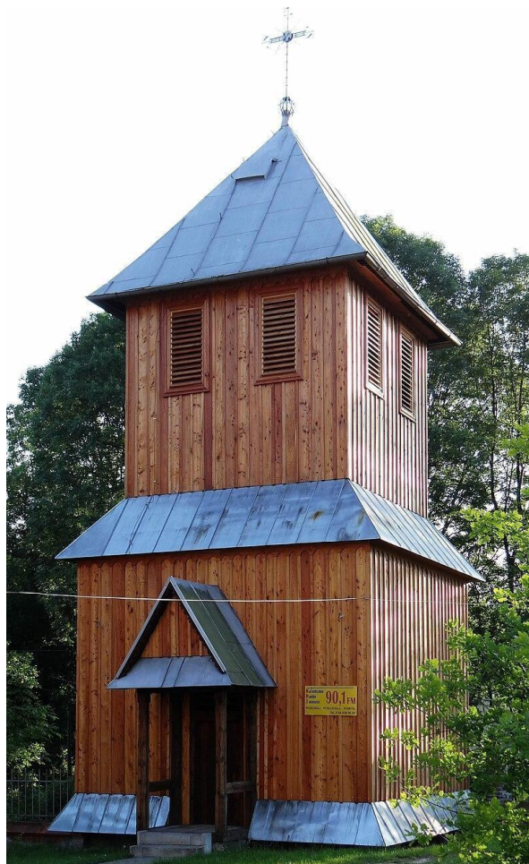
Zdjęcie 5. Drewniana dzwonnica przy Kościele pw. Najświętszej Maryi Panny w Krzeszowie
